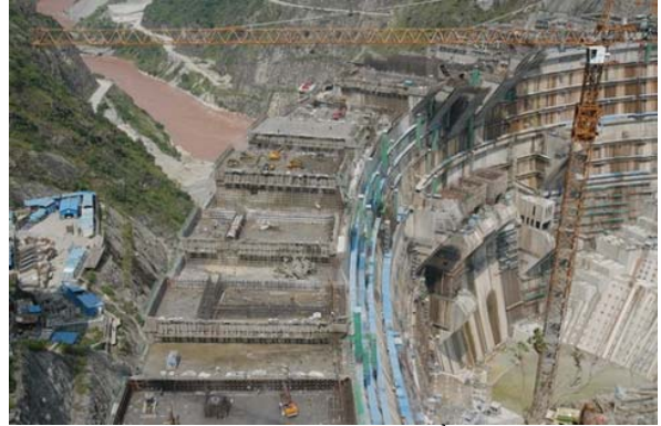
Đập Xiaowan đang được xây cất (Ảnh: Sinohydro)
