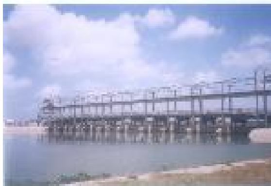
Cống đập Ba Lai (52)
